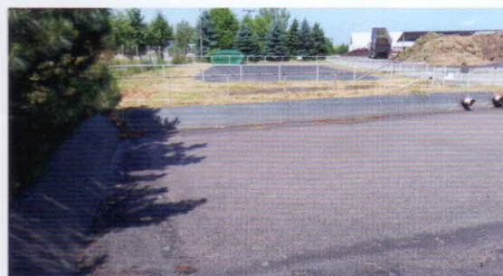
Záchytná jímka – znečištěná voda je svedena do I. záchytné jímky (objem 180 m 3 ). Z I. jímky je voda přečerpávána do záchytné jímky č. II – objem 300 m 3 . Konstrukce obou jímek – železobetonová s použitím plastové fólie. Voda akumulovaná ve sběrné jímce může být zpětně využívána na zkrápění kompostu
