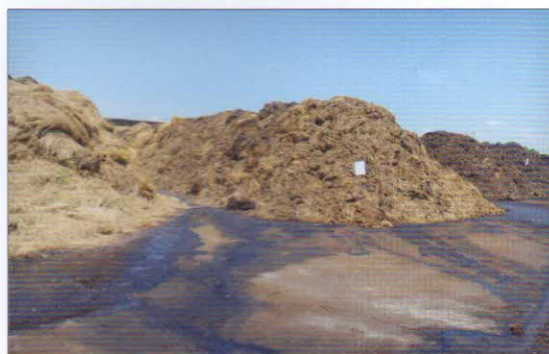
Kompostovací plocha 2, vodohospodářsky zabezpečená, vyspádovaná do sběrného kanálu, povrch plochy je asfaltbetonový; rozměry plochy 60 x 50 m, celková velikost kompostovací plochy – 3000 m 2
